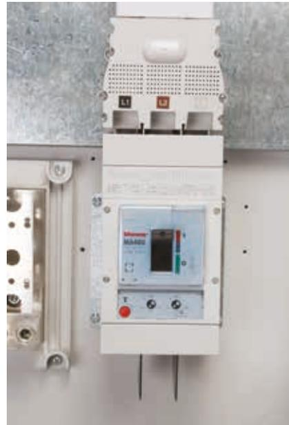
Los tableros NBAR 1250 cuentan con la preparación para instalar los interruptores principales utilizando los interruptores Megatiker de la capacidad requerida.
