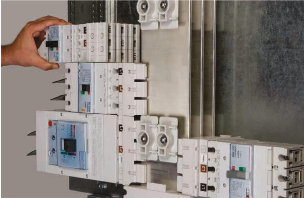
Para instalar los interruptores derivados en modo enchufable; basta asociarlos con el módulo enchufable correspondiente:
