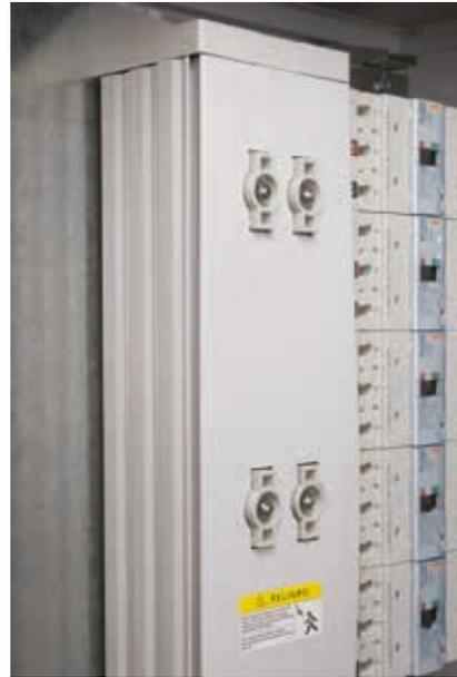
Un perfil aislante permite cubrir las barras principales en los espacios no utilizados; evitando así contactos accidentales con partes energizadas.
