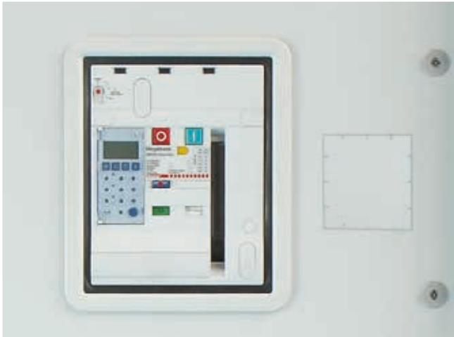
Los paneles frontales presentan una prerruptura para instalar el equipo de medición F3N300 o F3N400
