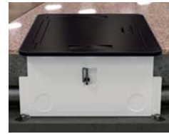
Piso de Concreto
