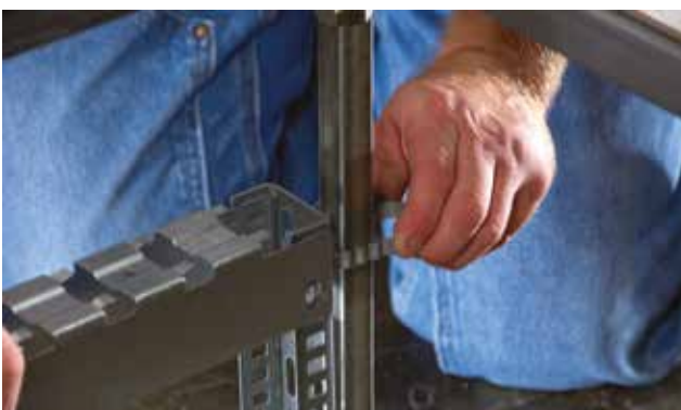
5. Dobla las pestañas del sistema FAS con un destornillador para asegurar la charola.
